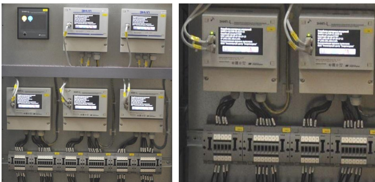
Рис 2. Подключение трансформаторов тока и напряжения с помощью измерительных блоков FAME от Phoenix Contact
